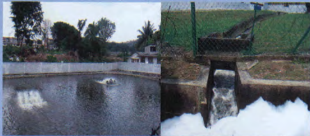
Effluen Dari Loji Rawatan Kumbahan Effluent From Sewage Treatment Plants
