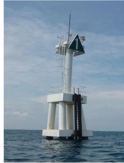
Stesen-stesen pengawasan kualiti air marin automatik dengan struktur beacon
