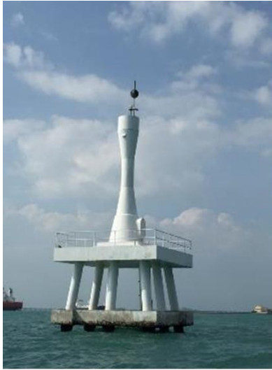
Stesen-stesen pengawasan kualiti air marin automatik dengan struktur beacon
