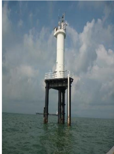
Stesen-stesen pengawasan kualiti air marin automatik dengan struktur beacon
